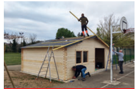
Construction d'un chalet pour le rangement des jeux d'extérieur de l'école
